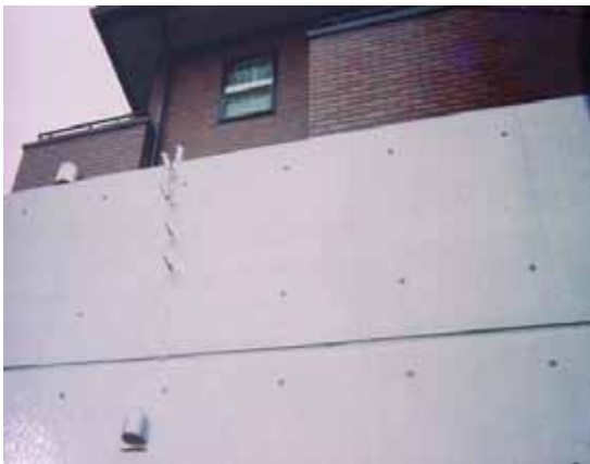
自動低圧注入施工
